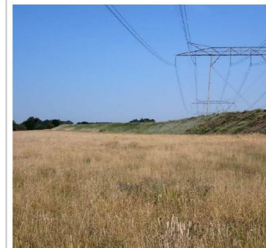
Vue depuis l'aval
