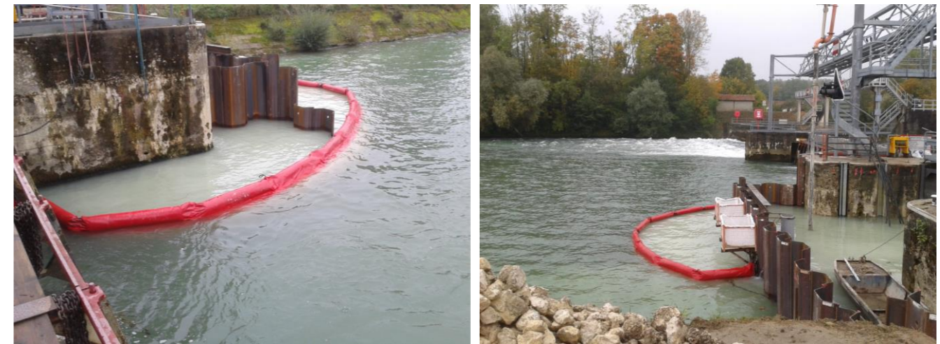
Photo 88 : Mise en place de barrage anti-MES
