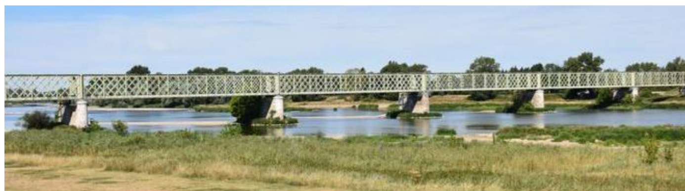
Photo 55 : L'ancien viaduc au-dessus de la Loire, reconverti en voie verte
