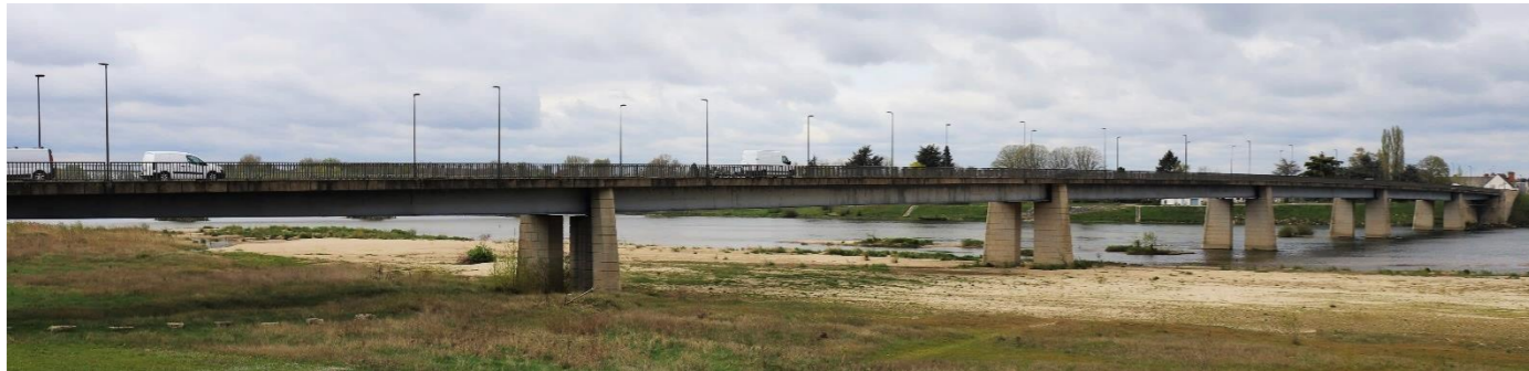
Photo 41 : Le pont de Sully-sur-Loire
