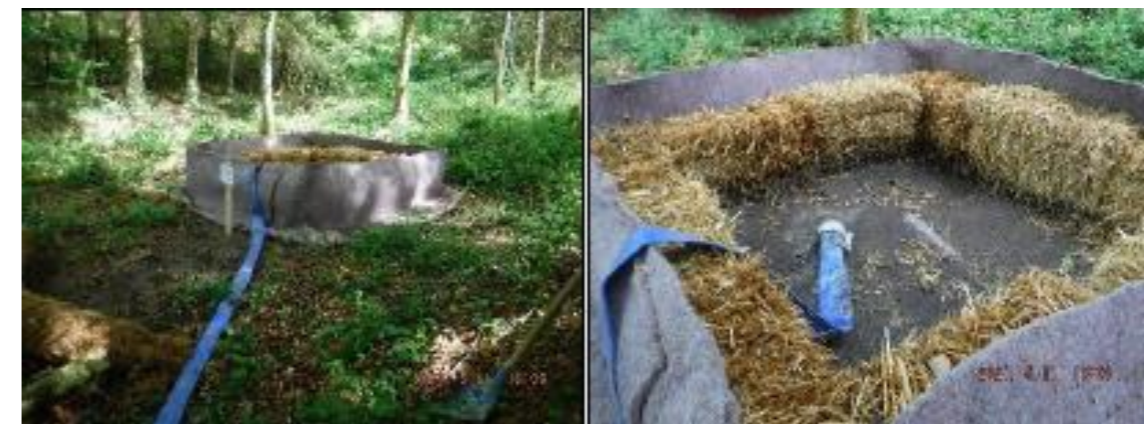
Photo 89 : exemple de bac de décantation équipé de filtre à paille pour la filtration des eaux turbides suite au terrassement.
