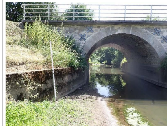
Exemple de pont à arche (commune de Saint-Martin d'Abbat)
