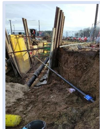
Figure 2 Route de la Motte à Bray : travaux effectués par GRDF - conduite d'eau sectionnée : intervention d'urgence de Yohann
